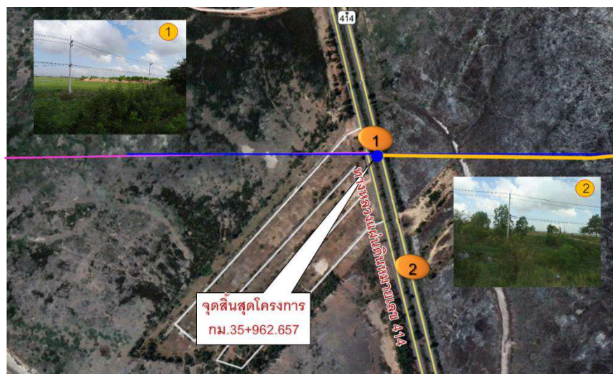
รูปที่ 3-3 สภาพพื้นที่บริเวณจุดสิ้นสุดโครงการ
