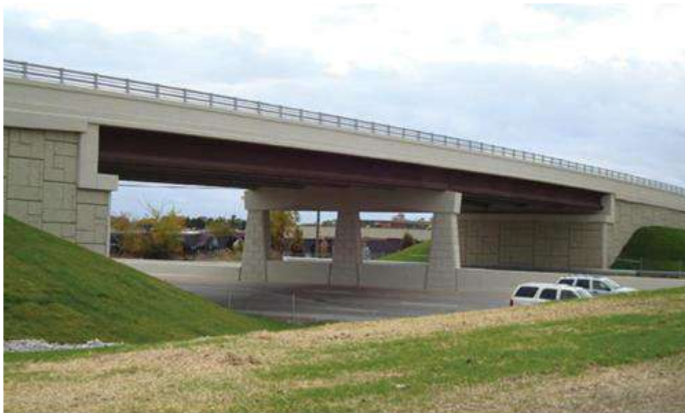
รูปที่ 36 โครงสร้างสะพานช่วงสั้น ช่วงความยาวไม่เกิน 20 เมตร
