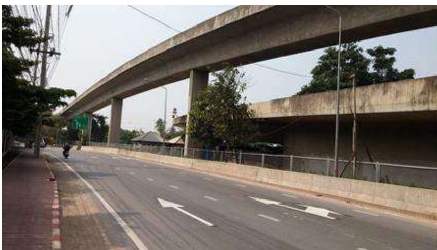
รูปที่ 35 โครงสร้างสะพานแบบ Box – Girder ก่อสร้างแบบหล่อในที่ ความยาวช่วง 40 เมตร
