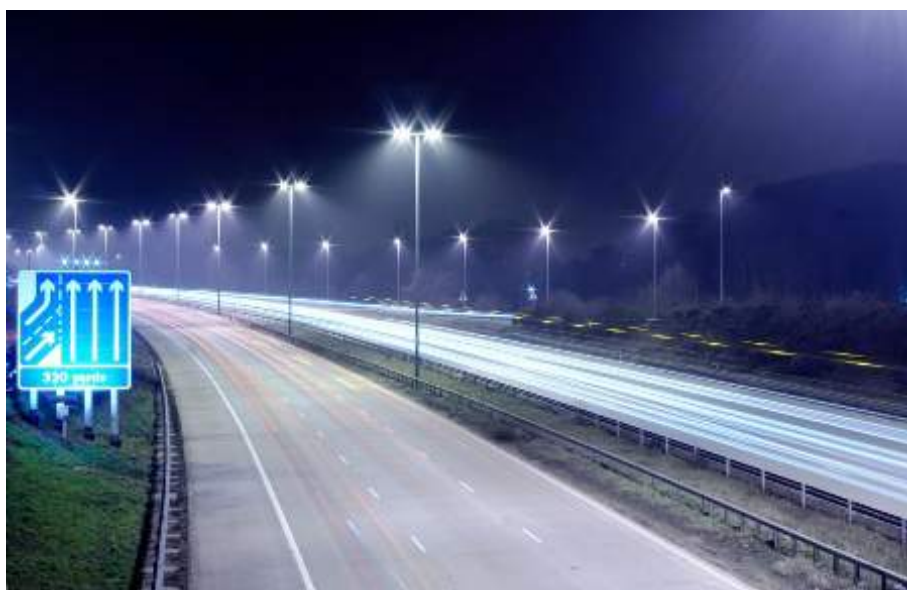
รูปที่ 23 แสดงภาพตัวอย่างการติดตั้งไฟฟ้าส่องสว่างผิวถนน
