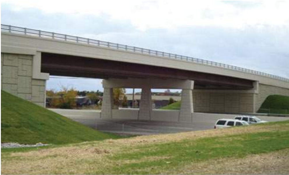
รูปที่ 18 โครงสร้างสะพานช่วงสั้น ช่วงความยาวไม่เกิน 20 เมตร
